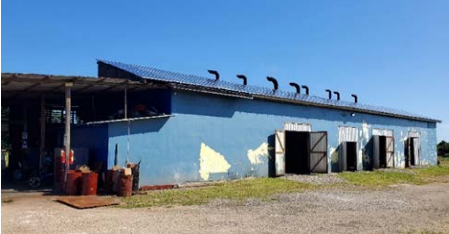
Ilustración 1 Vista de la planta de generación de UPCO
