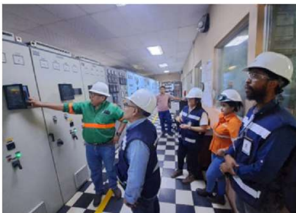
INSPECCIÓN EN LA SALA DE CONTROL.
