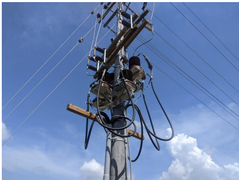
Imagen 16: Conexión privada con medición interna.
