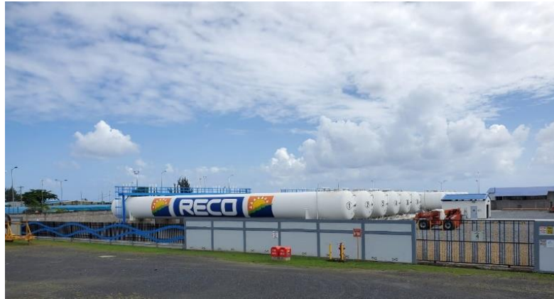
Figura 23 Tanque de almacenamiento gas LPG RECO
