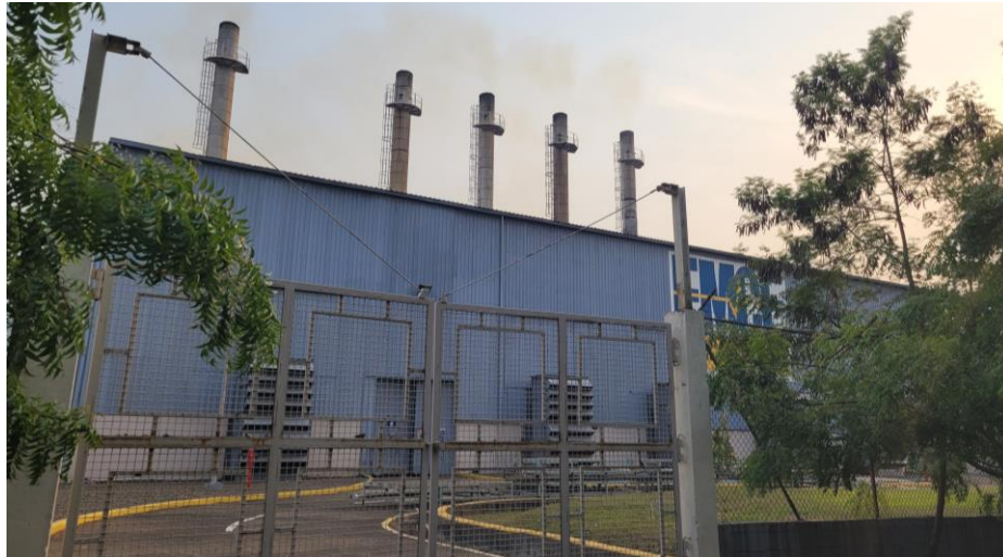
Figura 11 Instalaciones de la central térmica EMCE.
