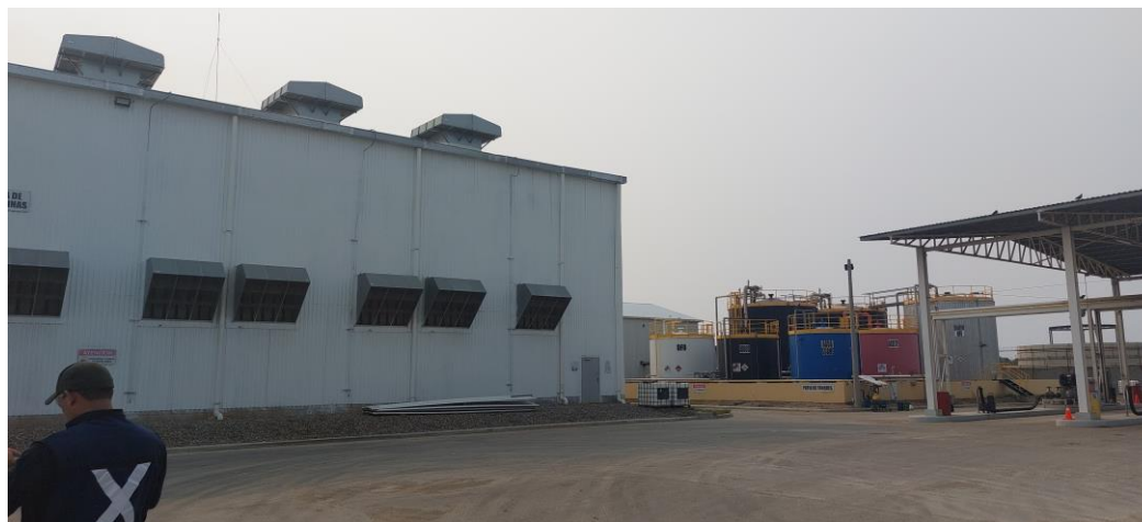
Figura 9 Instalaciones de la central térmica El Faro.
