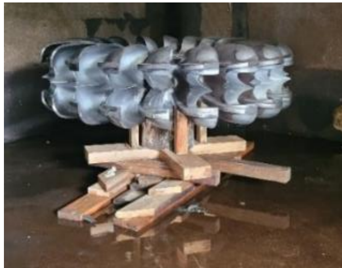
Figura 3 Reparación del rodete de la unidad 1.
