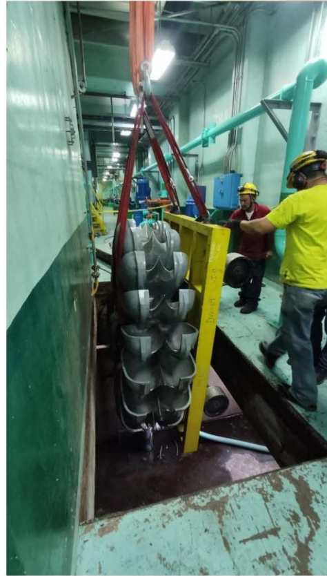
Ilustración 6. Montaje de rodete (24/05/23)
