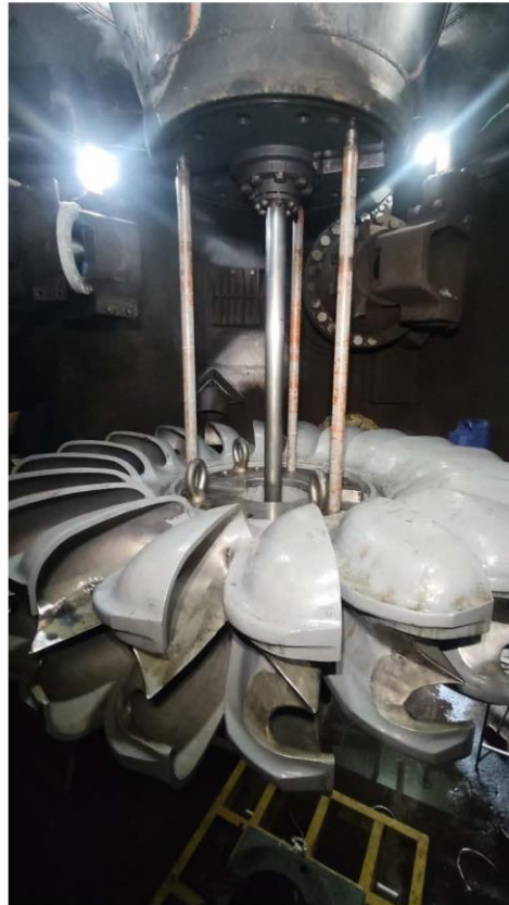
Ilustración 8. Montaje de rodete (25/05/23)
