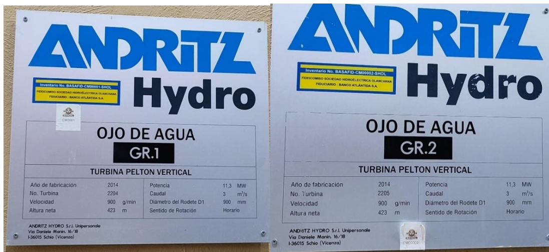
Figura 55 Unidades generadoras ANDRITZ Hydro 2014 que serán reemplazadas por ANDRITZ Hydro 2017
