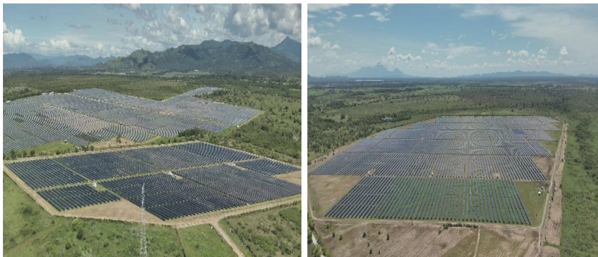
Figura 5 Unidades de generación de la central Helios (fuente propia)
