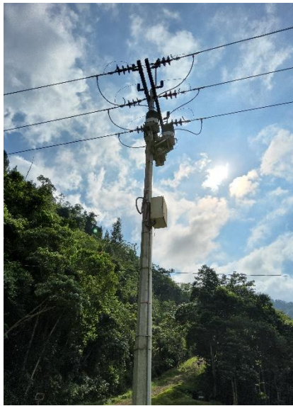
Figura 11 Red de salida de la central
